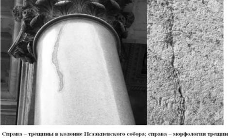
Слева — трещины в колонне Исаакиевского собора; справа — морфология трещины
